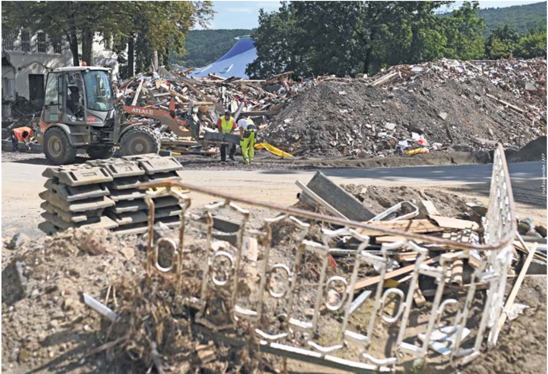
Zerstörungen in Bad Neuenahr im August 2021
