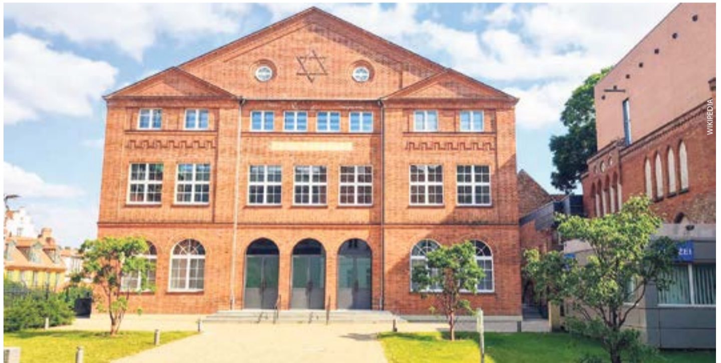
Die renovierte Carlebach-Synagoge in der Ostsee-Stadt Lübeck
