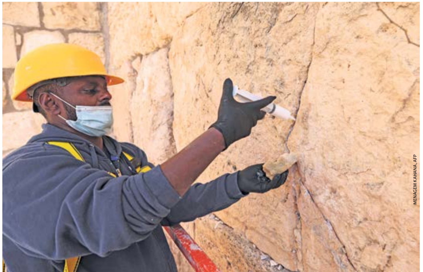
In die Risse der Steine wird verflüssigter Stein gespritzt, der später aushärtet.
