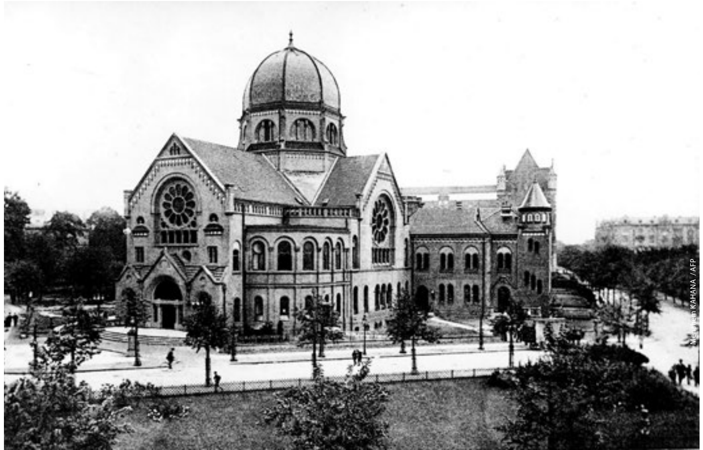
Blick von der Beneckestr. über Bornplatz und Binderstr. zur Synagoge mit Grindelhof (links), 1906
