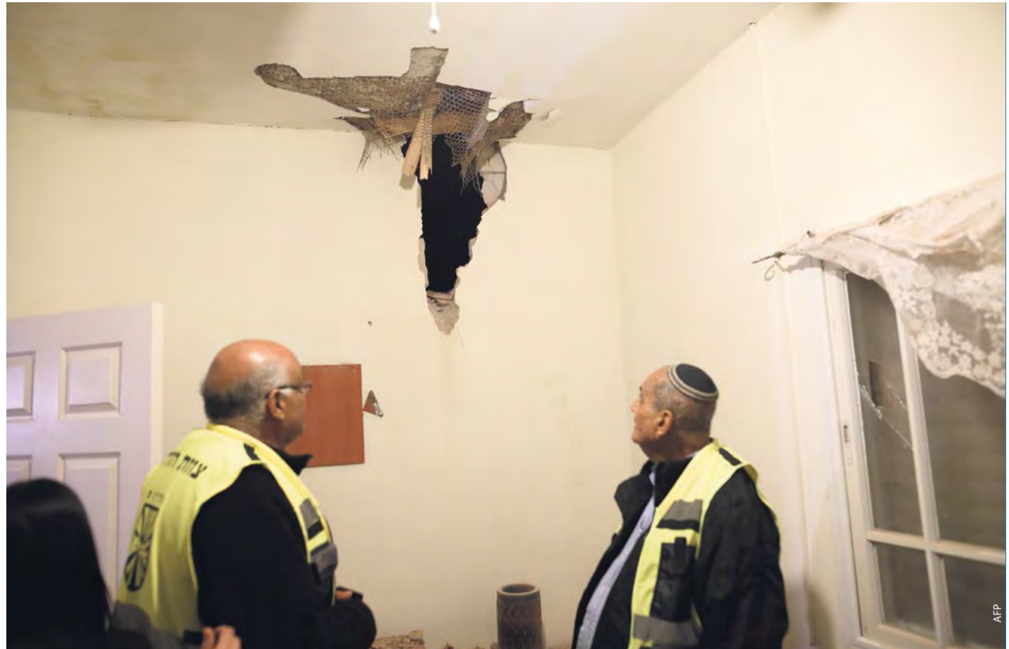
Helfer im israelischen Sderot besichtigen Schäden, die eine Hamas-Rakete angerichtet hat.
