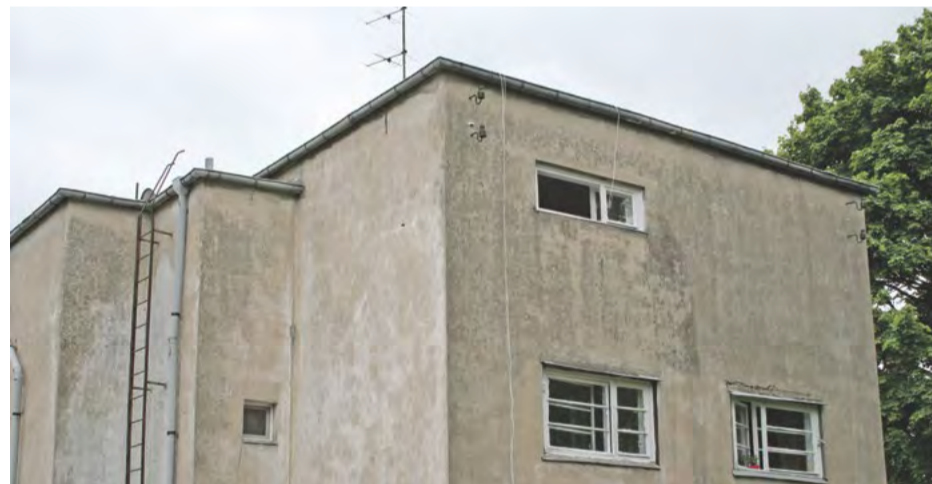
Rechts ist das Obergeschoss noch immer fensterlos
