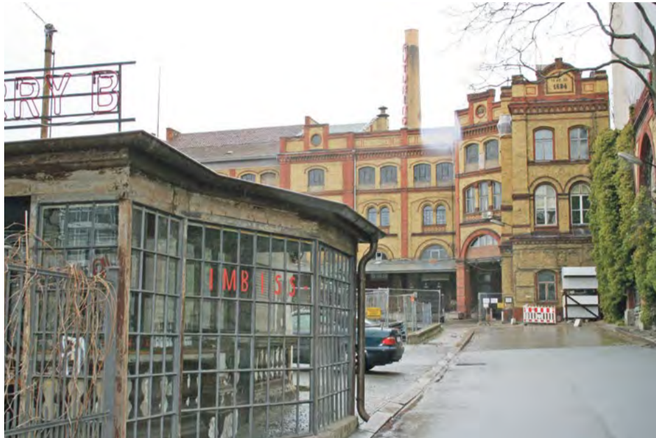
Die Bötzow-Brauerei im Berliner Stadtteil Prenzlauer Berg.
