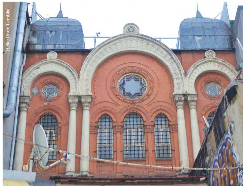
Das Portal der Ahrida Synagoge, eine der ältesten Synagogen Istanbuls, ist zwar nicht mit einer Betonmauer verbarrikadiert, aber trotzdem hoch gesichert.
